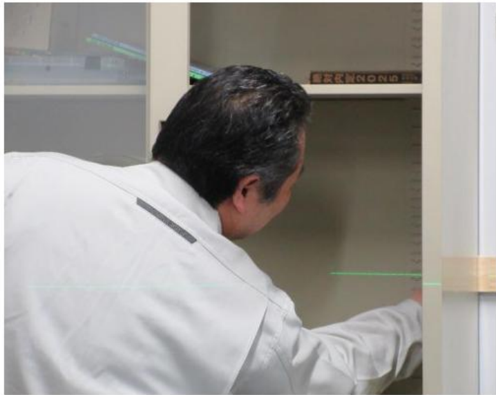
レーザー墨出し器を用いた水平位置の確認
