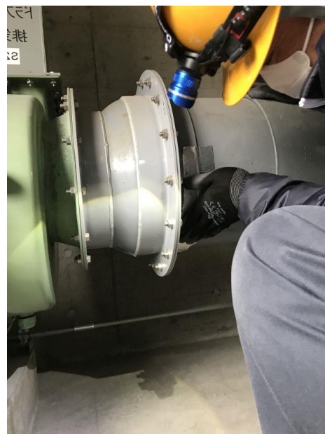
図2 補修作業の様子
