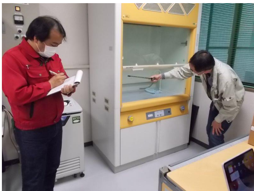
図1 局所排気装置自主検査の様子
